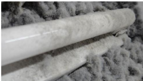
《照明器具に埃が堆積した例》
